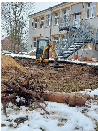
**Die Bauarbeiten** auf dem Foto links werden nicht, wie vielleicht von manchen Eltern erhofft, zu einem größeren Parkplatz führen. Stattdessen tauscht die Stadt die maroden Abwasserleitungen aus, die bereits von Baumwurzeln beschädigt waren.
